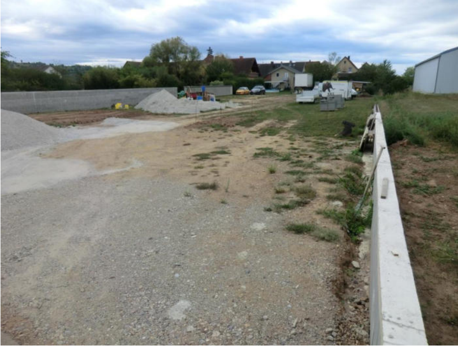
Abb. 1 Eingriffsbereich von Norden
