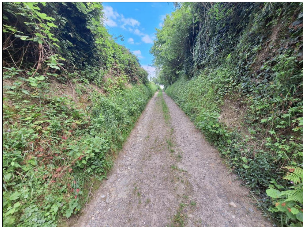
Abbildung 11: Hohlweg am Kahlenberg. Die Böschungen der Hohlwege im Bearbeitungsgebiet sind mehrheitlich zugewachsen. (L. Keil, 27.06.2024)
